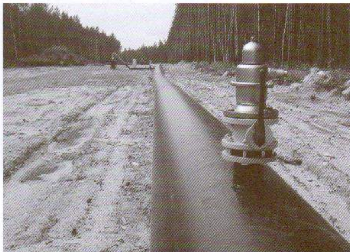
Ein Be- und Entlüftungsventil Typ 1.59 DN 100 im Einsatz beim Bergbau.
